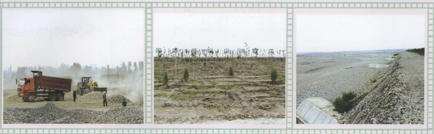
正在建设中的滨河新区施工工地
