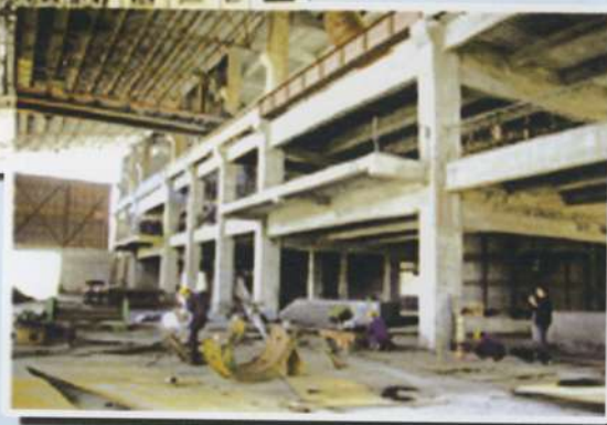
20万吨高纯硅一期5万吨工程 成为发展硅铁合金产业的龙头项目
