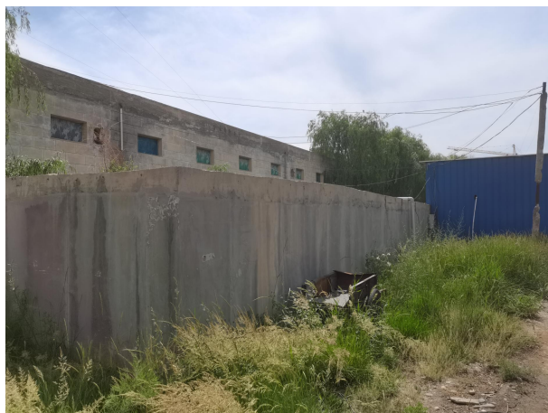
甘肃甘绿脱水蔬菜股份有限公司污水处理站
