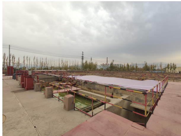
张掖市大弓农化有限公司污水处理站
