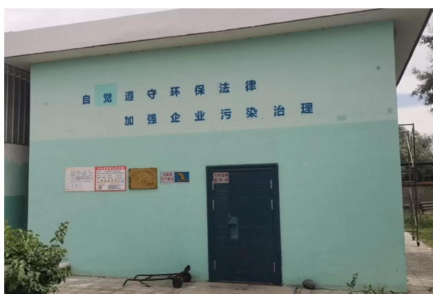
甘肃雪源啤酒原料有限责任公司污水处理站
