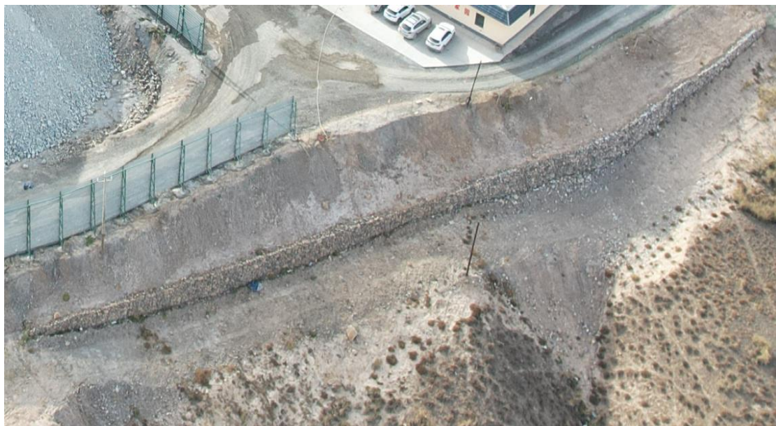
图 2-13 办公生活区东侧挡土墙
