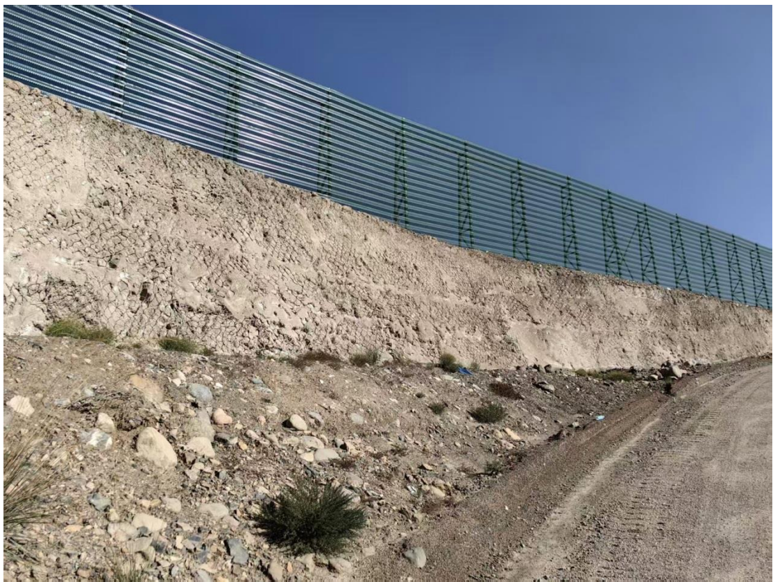
图 2-12 矿石临时堆场防尘网及挡土墙
