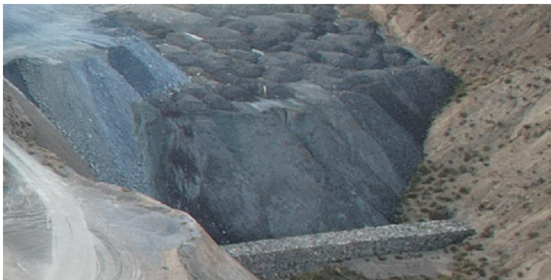
图 2-15 排土场挡土墙
