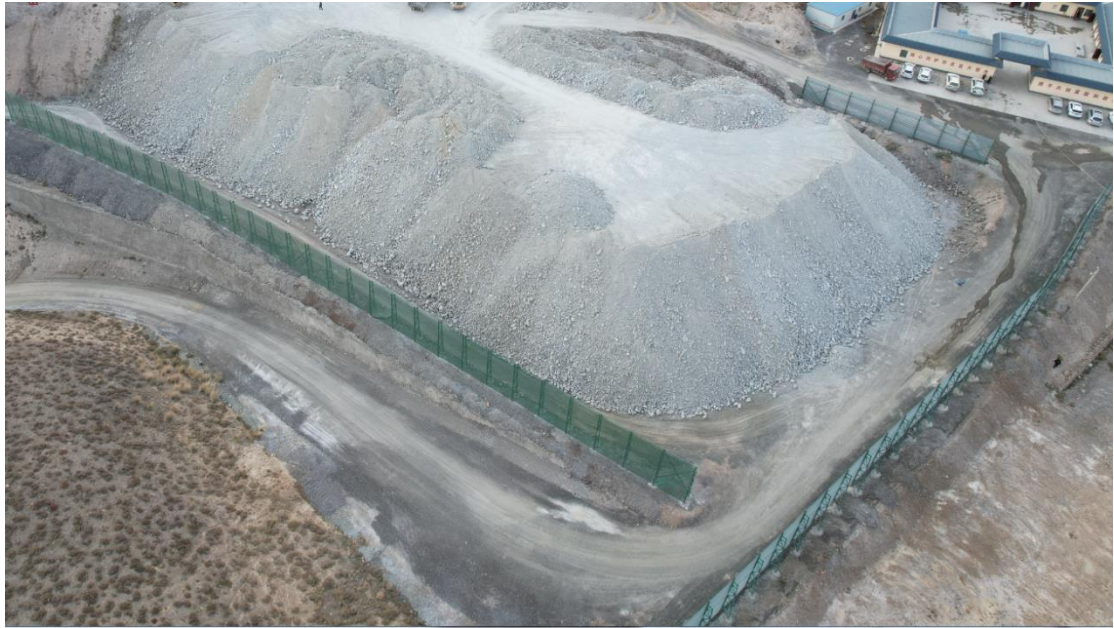
图 2-11 矿石临时堆场防尘网
