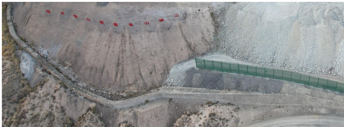
图 2-14 矿石堆场南侧挡土墙
