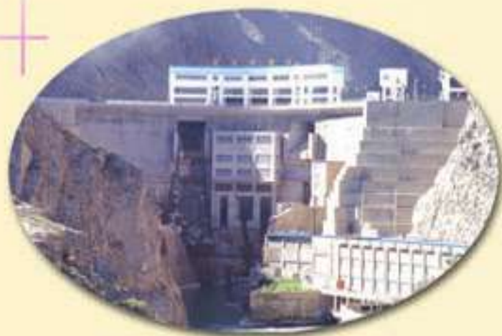
龙首二级水电站
