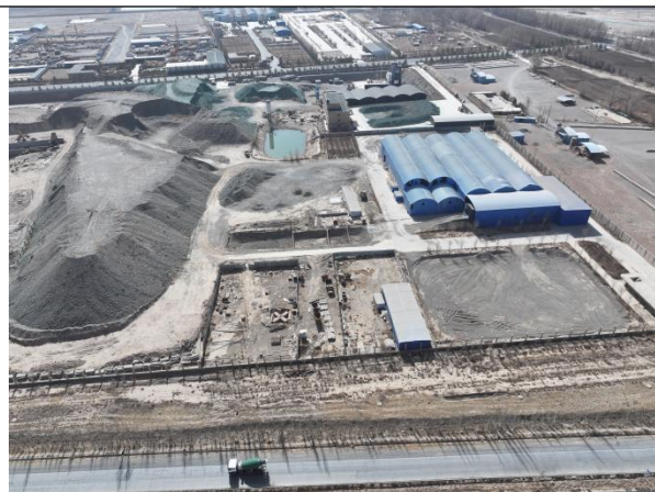
厂区西南侧（砂石料为该厂区的物料）
