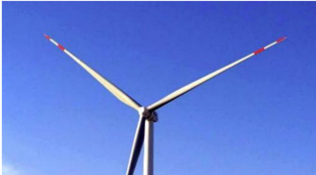
图 5-2 艳化风机叶片示意图
