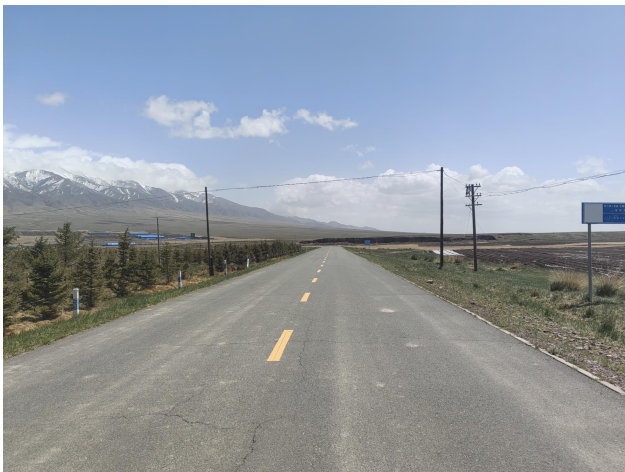
维修利用段穿越水源保护区路段现状
