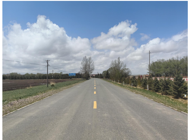
维修利用段道路现状
