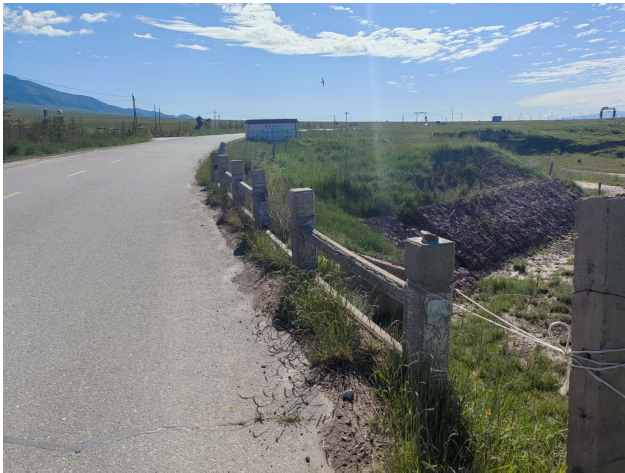
维修利用桥梁现状（仅对护栏维修）
