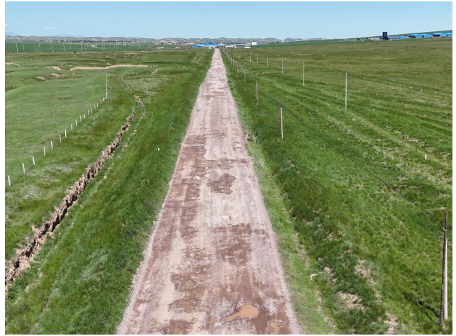
改建段道路现状
