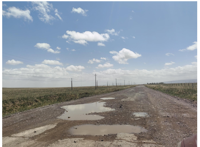
改建段道路现状
