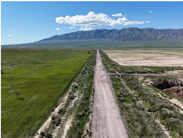
改建段道路现状
