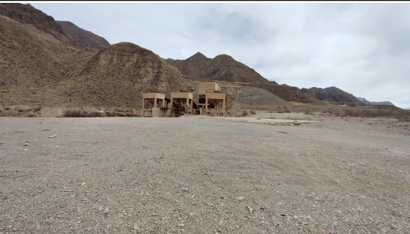
照片 1-1 拟建工业场地 1#
