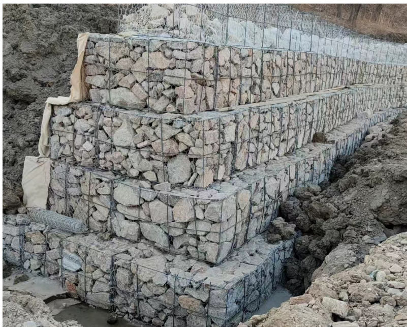
图 4-2 铅丝石笼拦渣坝施工图
